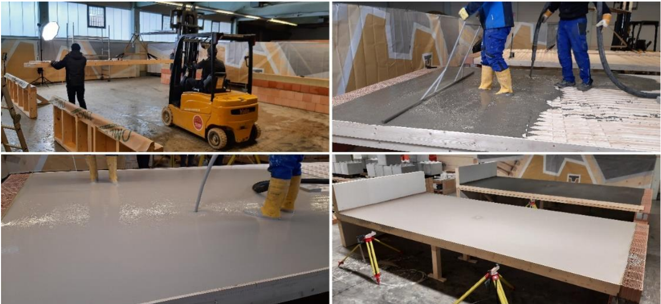
Abbildung 36: Herstellungserprobung von HBV-Testdecken
