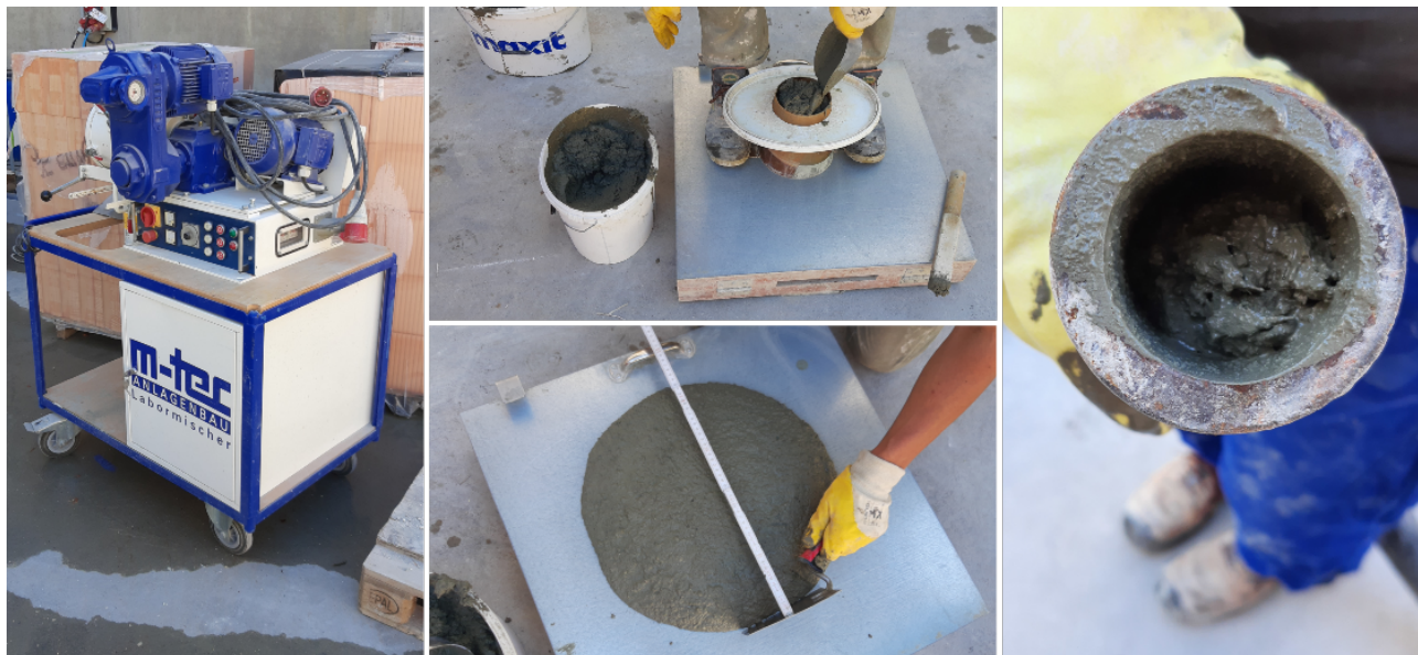
Abbildung 35: Praxiserprobungen von faserbewehrtem Beton in Silomischpumpen
